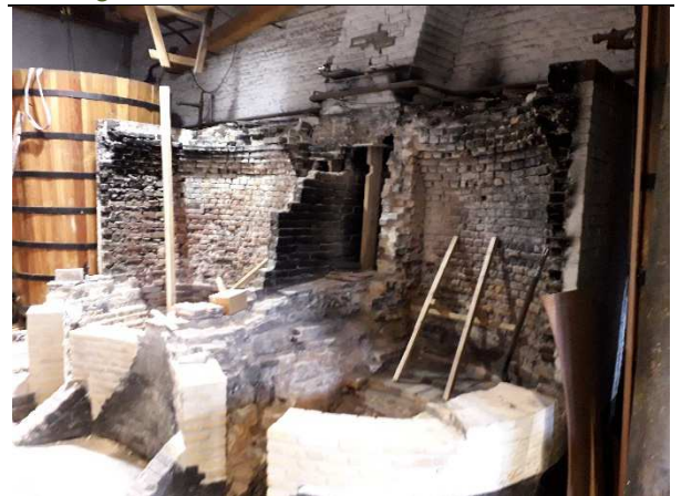
De ketels en de ketelwanden zijn verwijderd. Er is al begonnen met het op metselen van de ketelwanden. (foto Jos Poolman)
